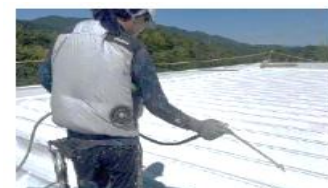
工場屋根の遮熱塗装施工
